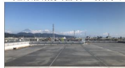
本館屋上(緑化工事前)
