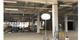
建築設備科実習場
